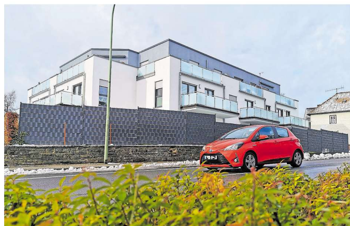
Neubau an der Bundesstraße in Imgenbroich: Aufgrund der mitunter starken Verkehrsbelastung eine tendenziell eher „einfache bis mittlere Wohnlage“ im Sinne des Mietspiegels. FOTO: MARCO ROSE
