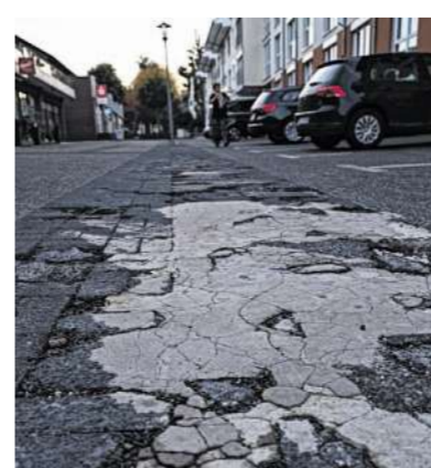
Dringend sanierungsbedürftig: Der Rathausplatz in Simmerath. Foto: P. Stollenwerk
